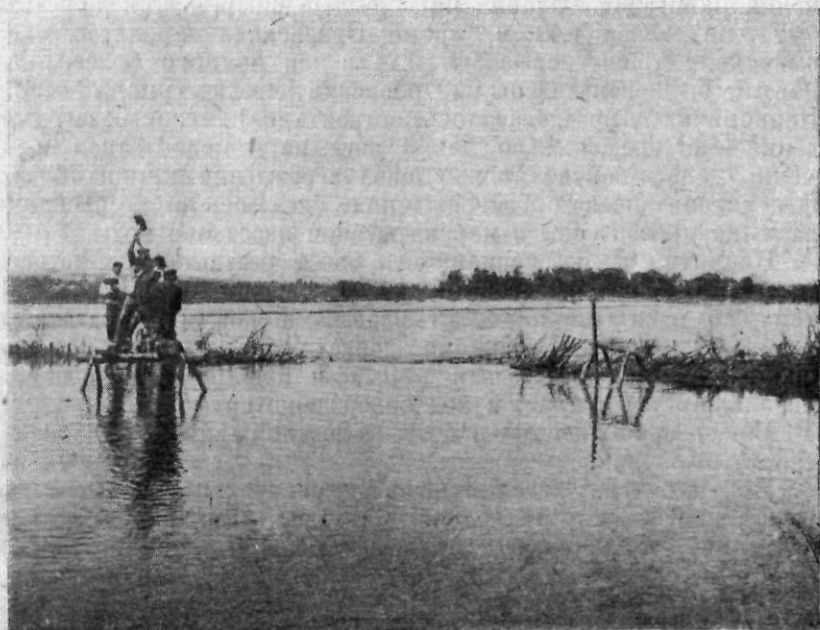
Рис. 19. Заделка прорванной части плетневого забора.
